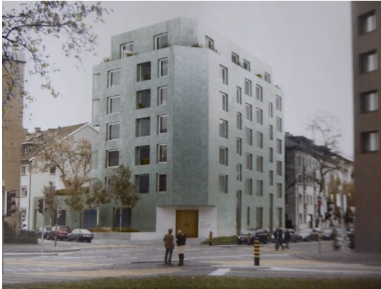
Das geplante, neue Odd Fellow Haus, Grosspeterstr. 5, 4052 Basel
